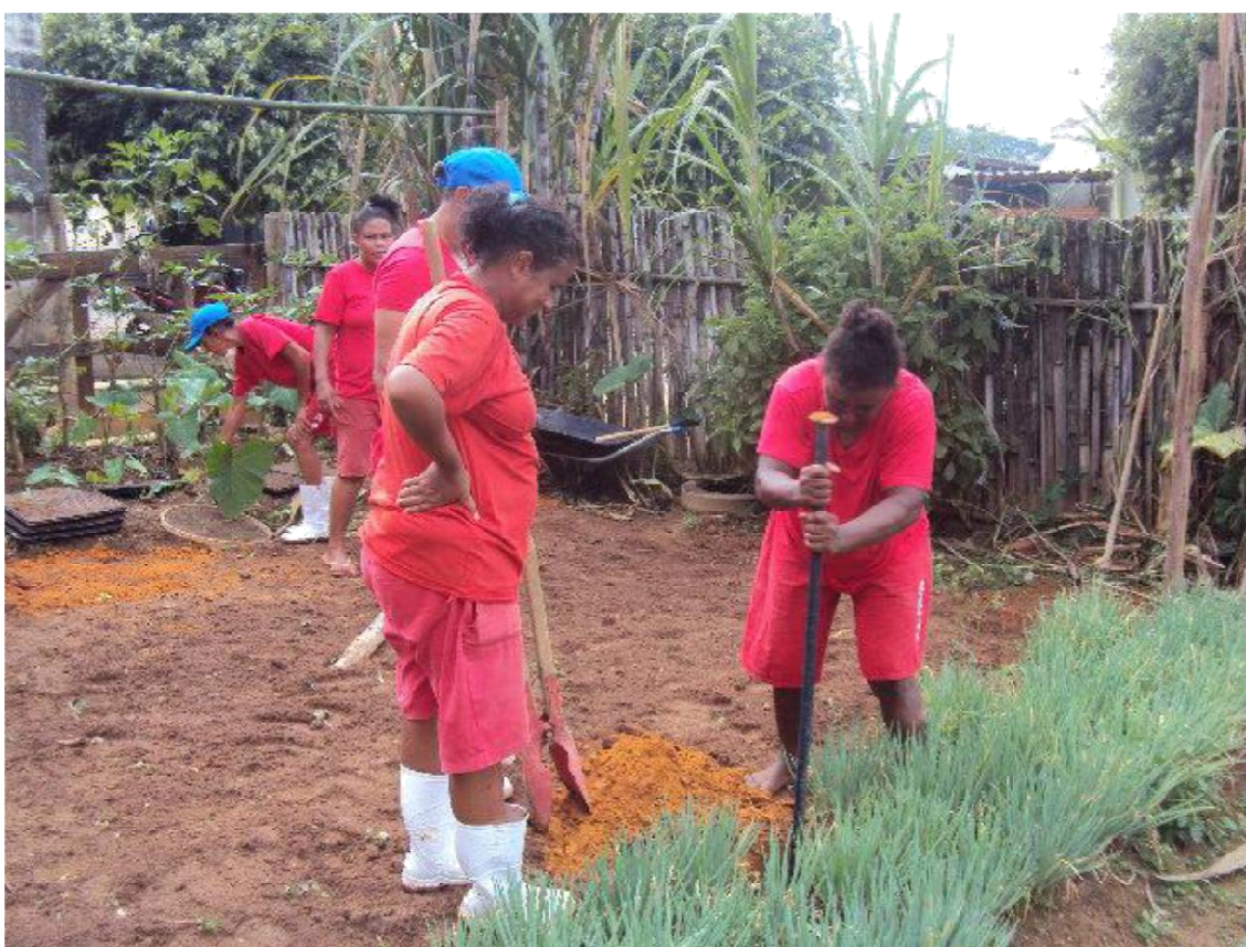
Construção da estufa
