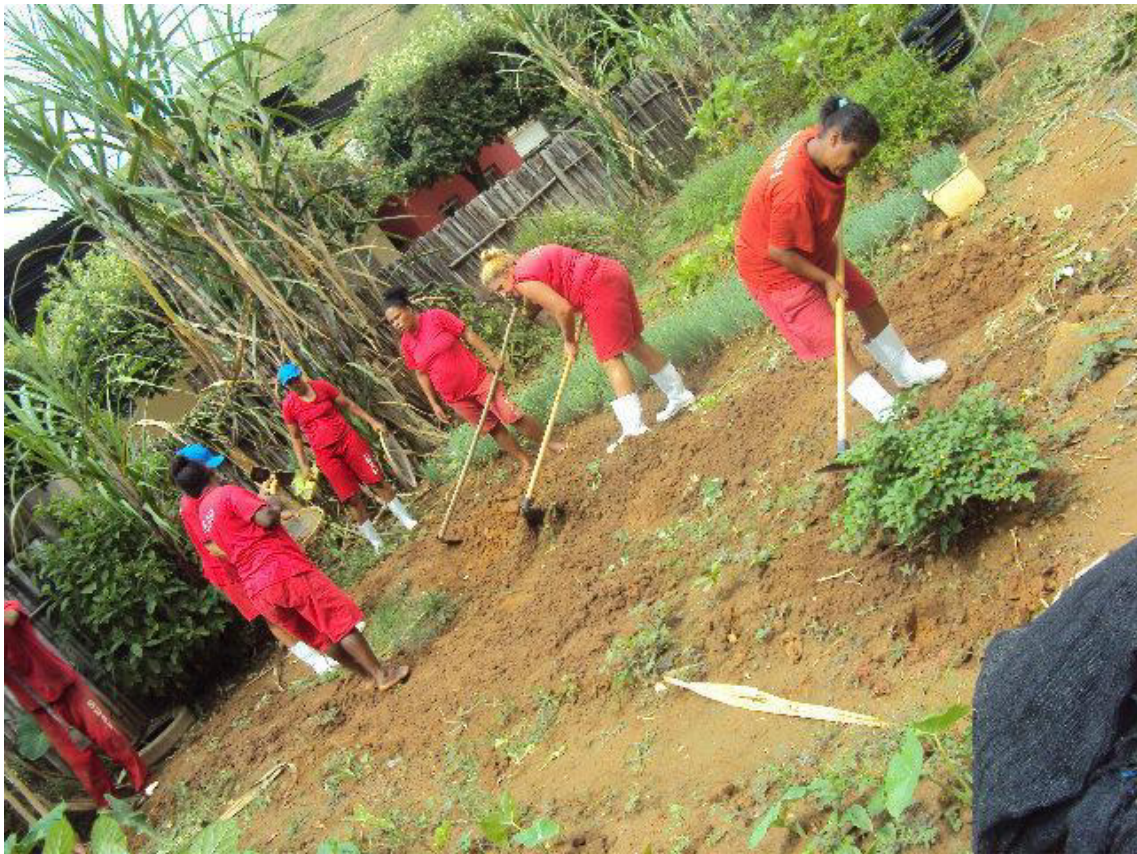
Limpeza da área para construção da estufa.
